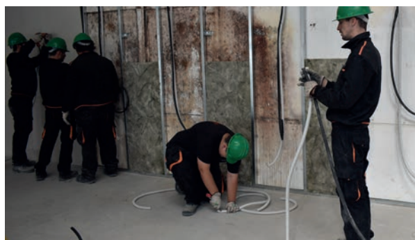
Dos participantes del proyecto trabajan en la instalación eléctrica en una obra.
